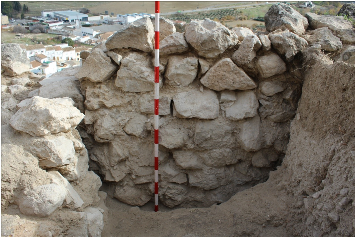
Lámina IV. Sondeo 1. Potencia del lienzo de muralla en su cara interna.
