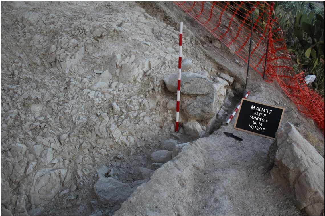
Lámina XXI. Sondeo 4. Detalle de los restos del muro de contención UE 14.
