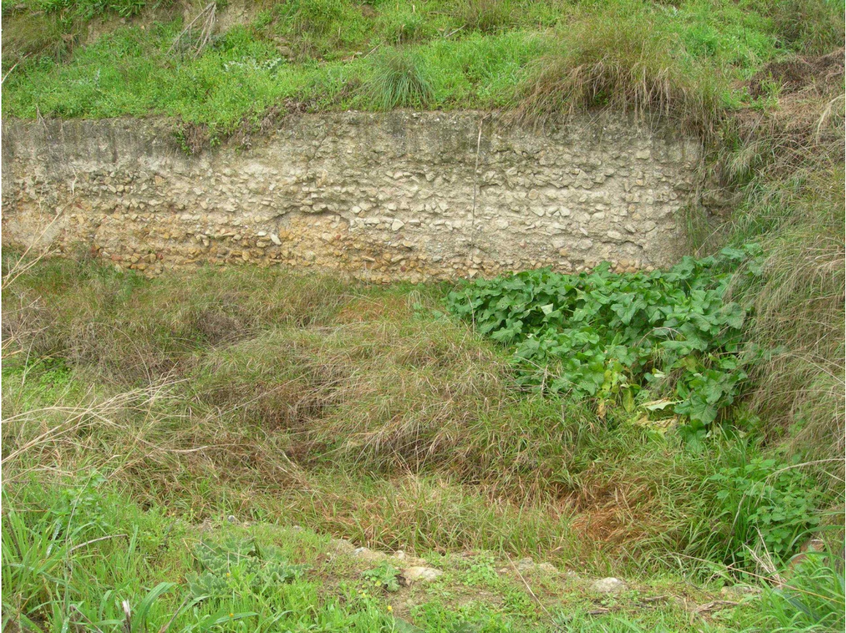
Figura 10. Estado actual de una de las piscinas romanas – vaciada en la década de los 80 del siglo XX - de la zona conocida como Fuente de Teba. ©M a del Camino Fuertes Santos.
