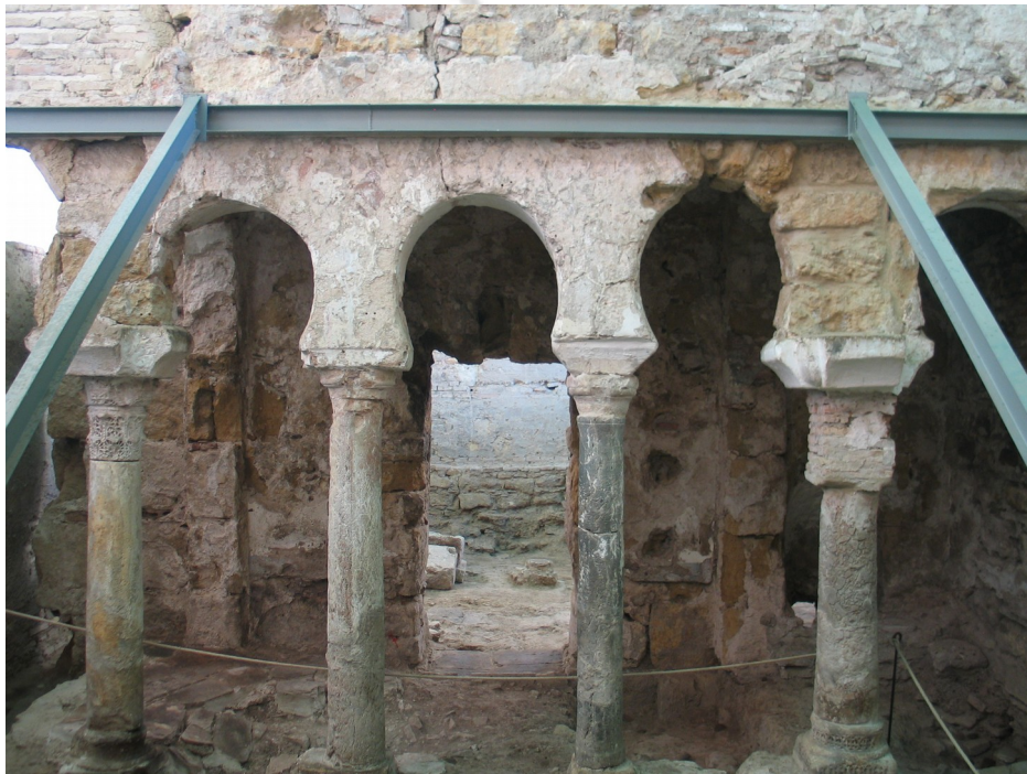
Lám III-. Arquería oeste de la Sala Templada
