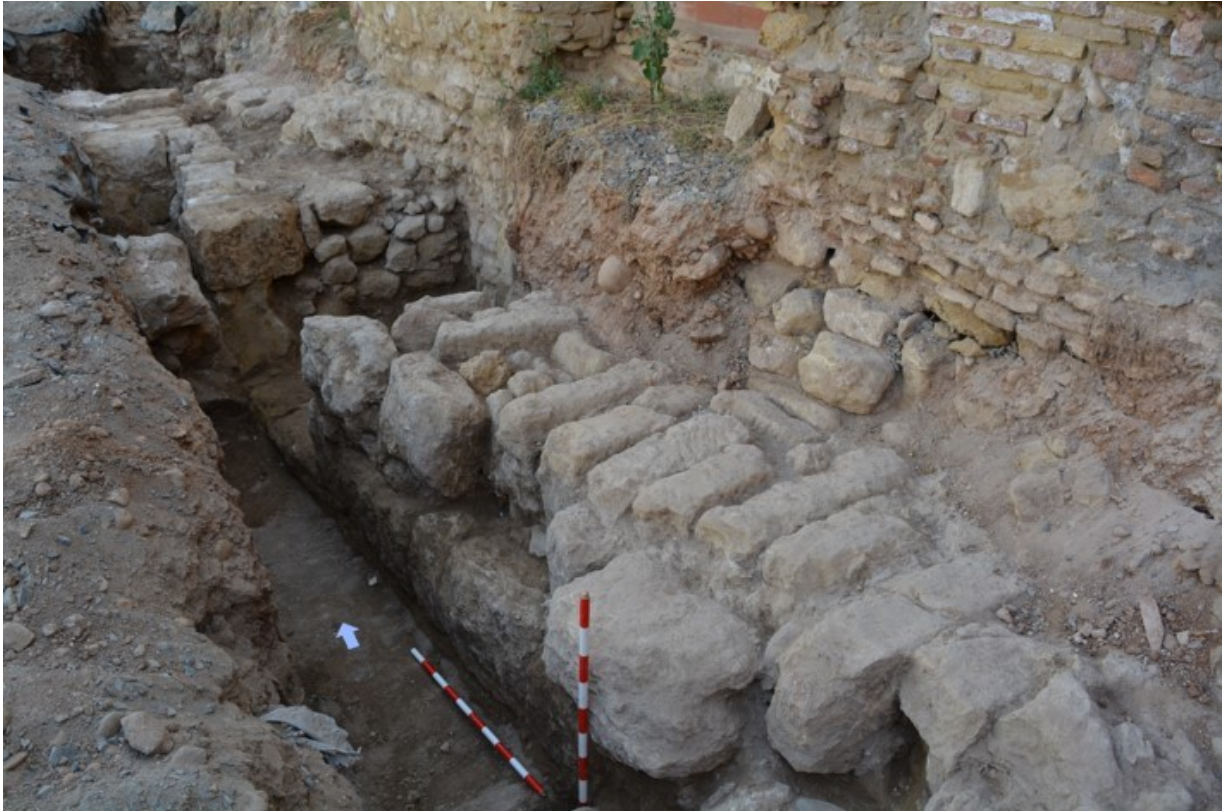
Lám. V. Superposición de paramentos de la muralla: Estructura de sillarejos (UC59) de Época Andalusí sobre UC51: paramento de Época Romana.
