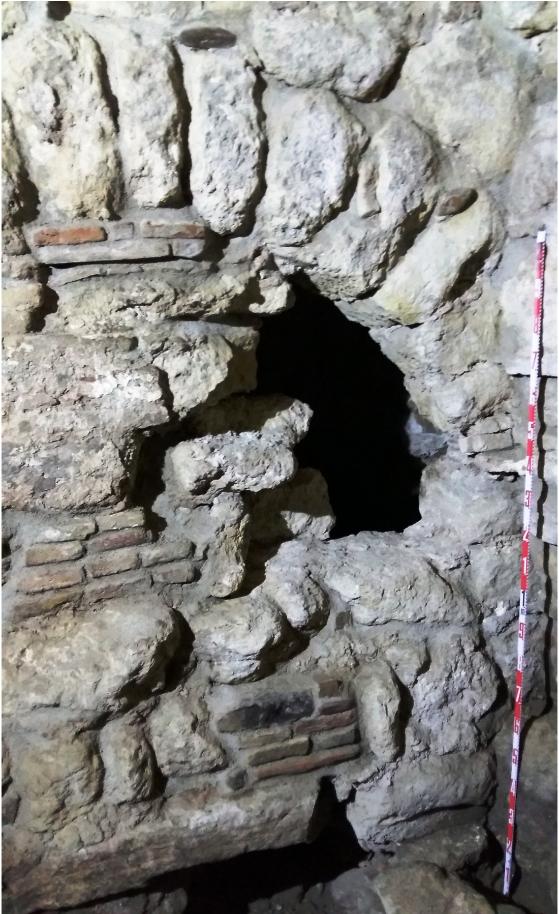
Lám.03.- Bóveda de acceso del aire que calentaba la Bayt al-Sajum.
