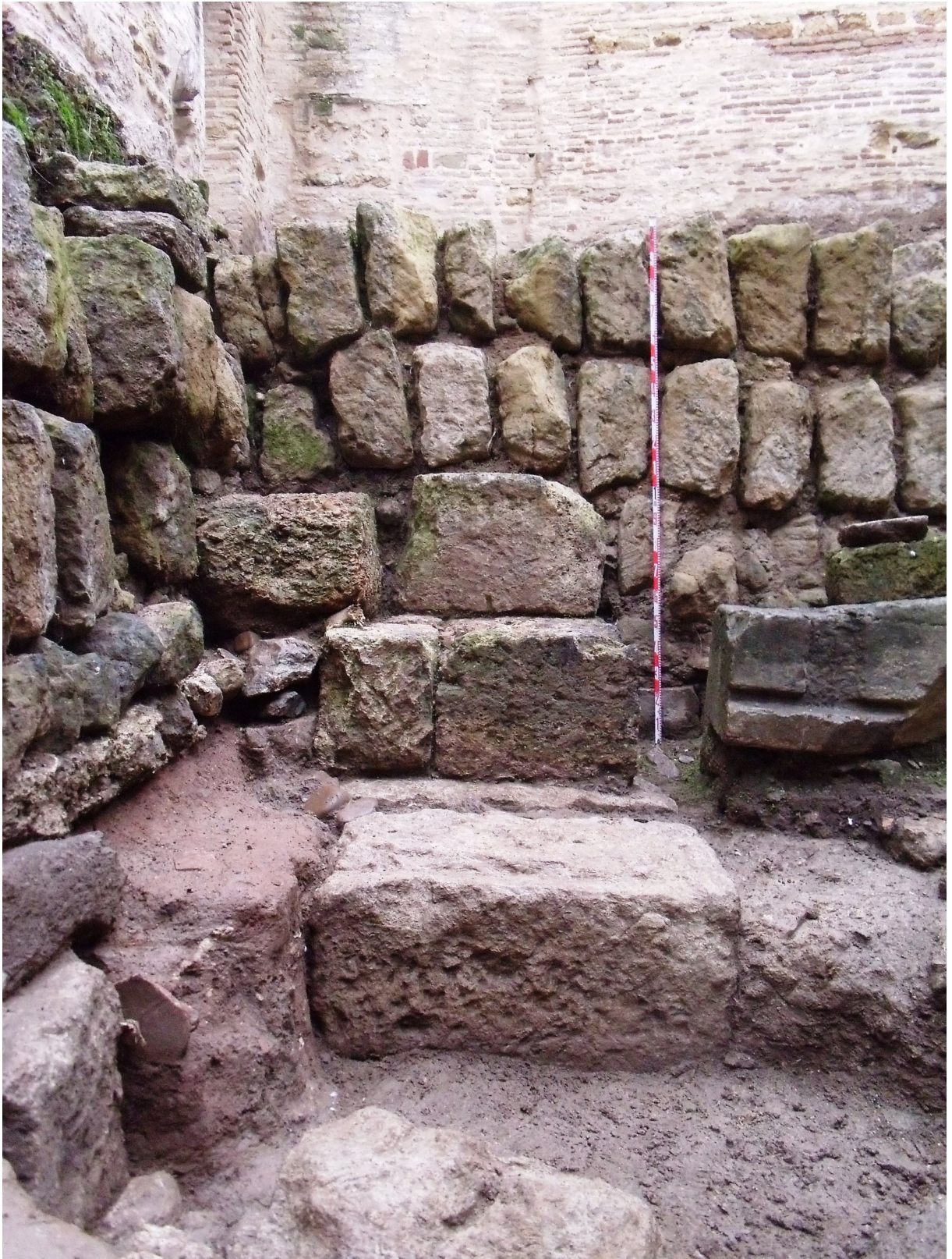
Lám.01.- Cimentaciones del baño islámico sobre estructuras romanas.
