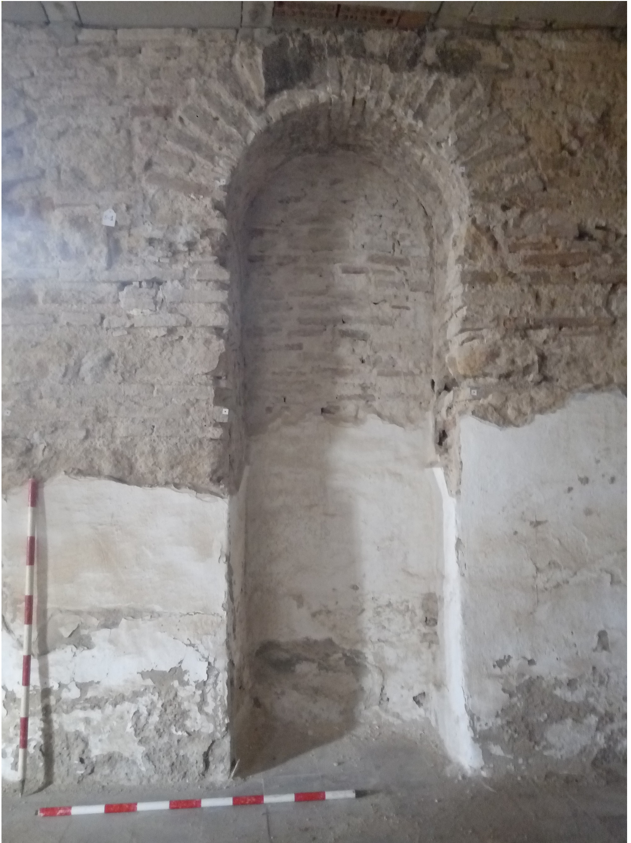
Lám. 1. Picado de Paramento M 01
