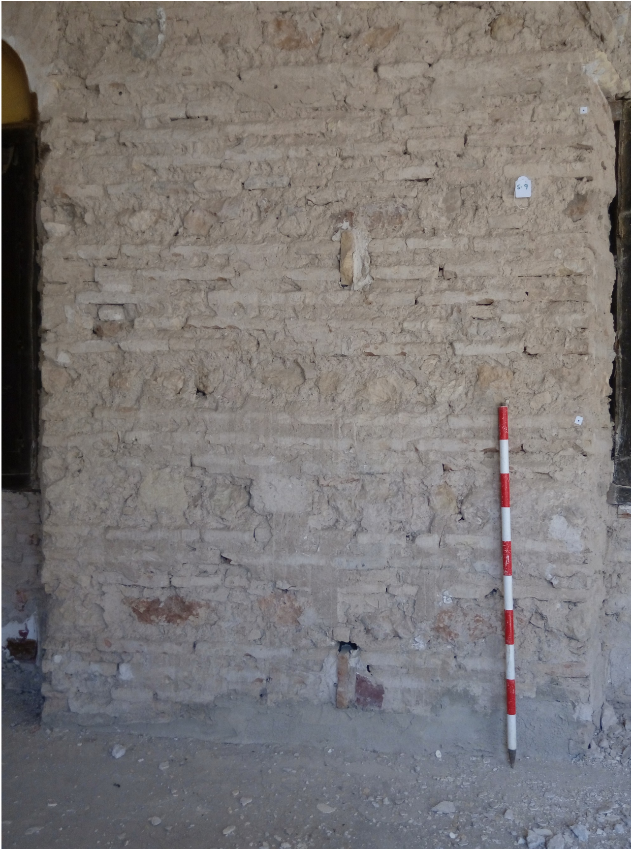
Lám. 3. Utilización del aparejo mixto de ladrillo y piedra calcarenita sobre M 09.
