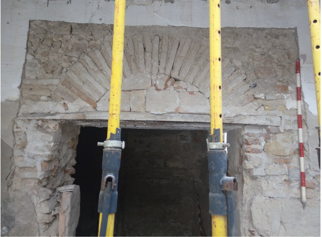
Lám. 4. Arco de ladrillo (u. e. v 125.) y dintel de madera ( u.e.v. 123) sobre M 02.
