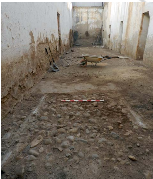
Lámina 2. Preparación del pavimento de la nave (UEC0002) y regladas de yeso (UEC0003).
