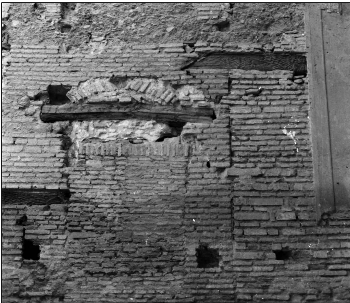
Imagen: Vista 29 del arco de descarga y la viga asociadas a la puerta moderna UE- 075.
