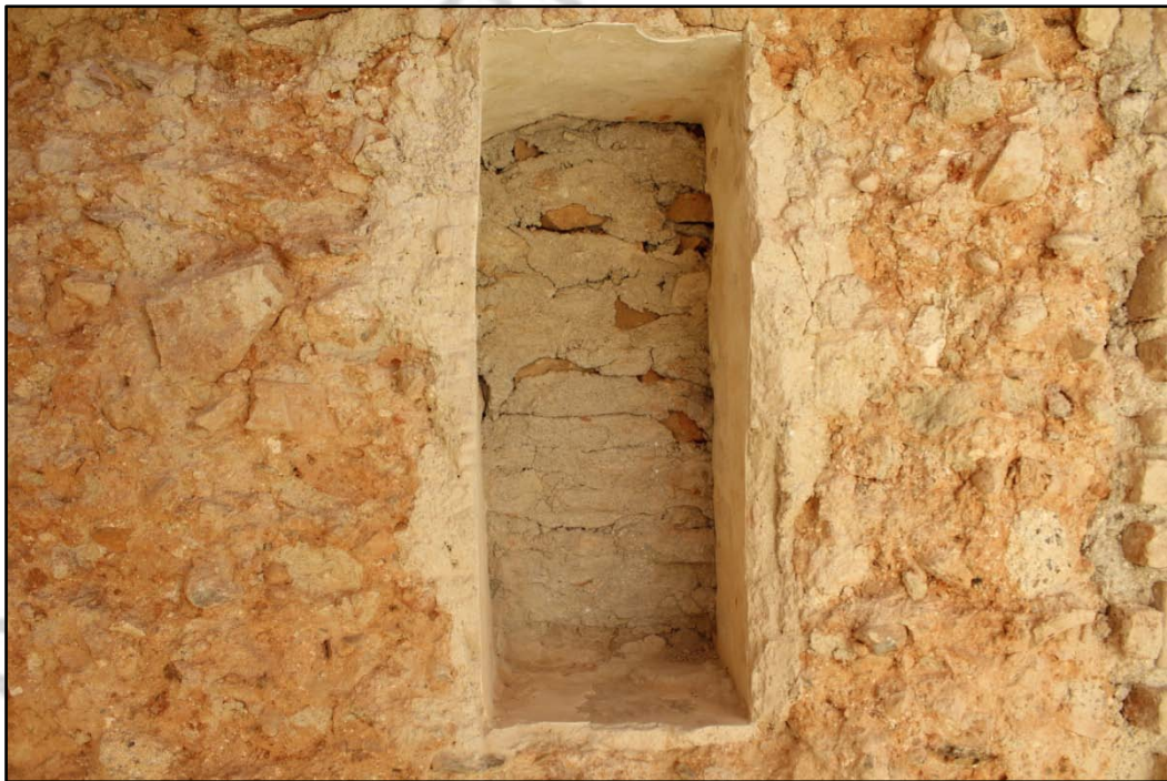
Imagen: Vano nazarí con marco de mortero de yeso, UE-010, realizado en el tapial.
