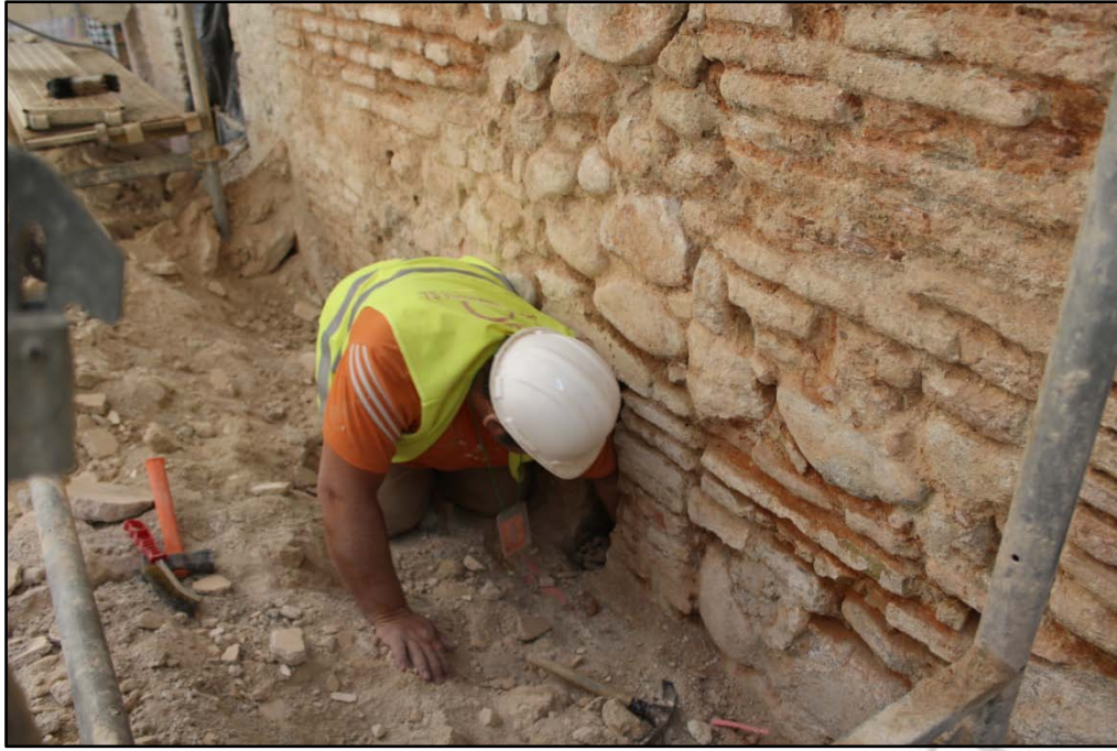
Imagen: Momento de la limpieza de la canalización UE-071 localizada durante la intervención.
