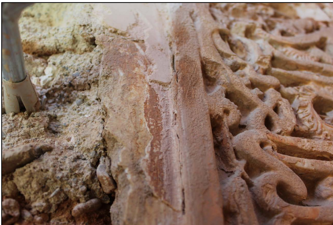
Imagen: Detalle del enlucido UE-001 apoyando en el enlucido de yeso nazarí UE-080.
