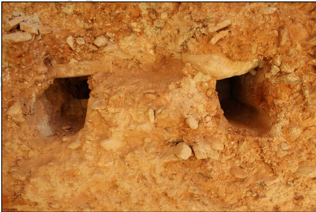
Imagen: Detalle de las oquedades de mechnal empleados en la construcción del tapial, se aprecian los ladrillos que sostenían la aguja de madera, ya desaparecida.
