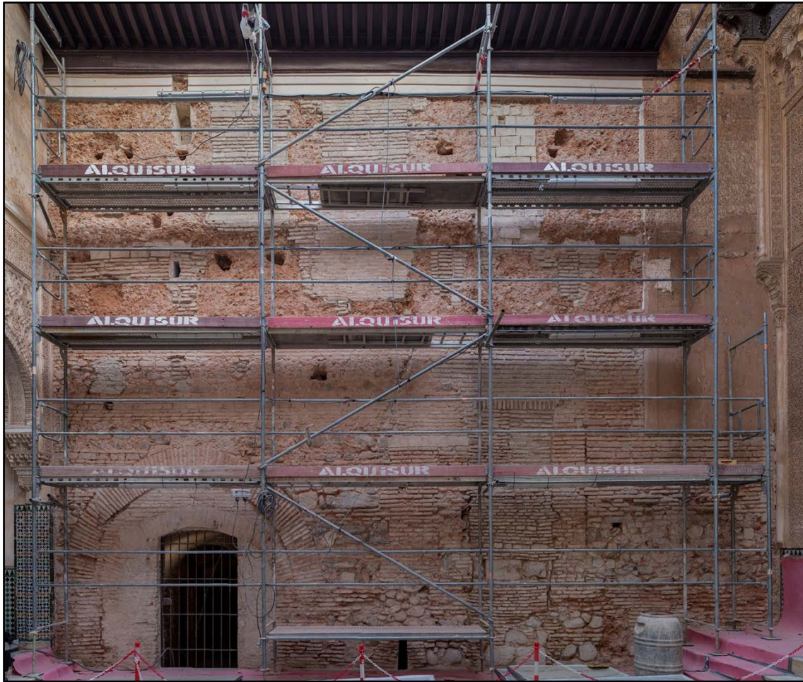
Imagen: Vista del muro oriental del Cuarto Dorado liberado de los enlucidos contemporáneos. Fotografía de Pepe Marín.
