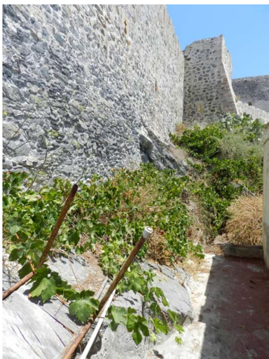
Lámina VI. Zona trasera de actuación, antes del inicio de los trabajos.
