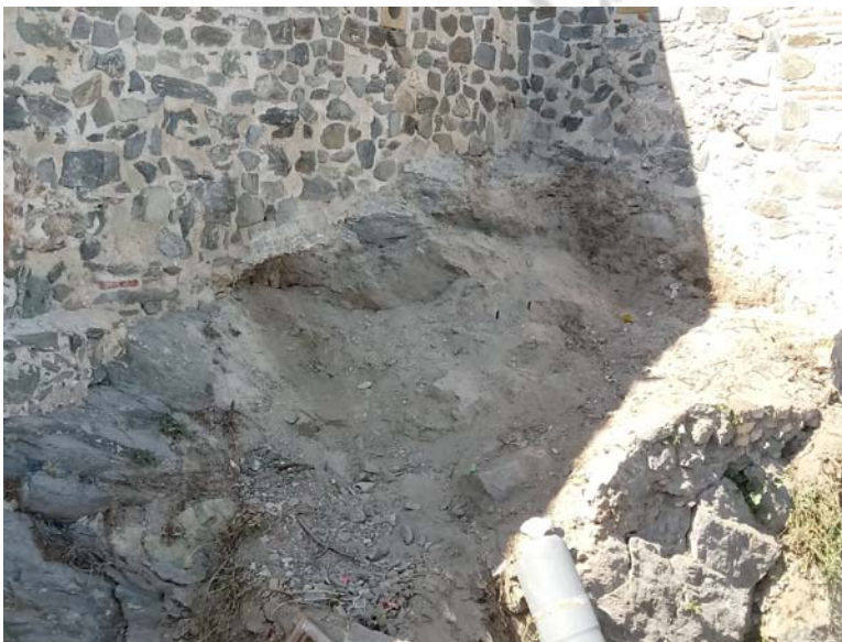
Lámina IX. Estado final tras eliminar las jardineras contemporáneas.
