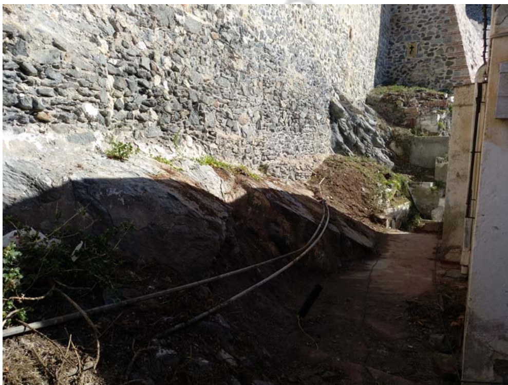
Lámina VII. Zona tras el inicio de la limpieza de escombros, tierras y vegetación.
