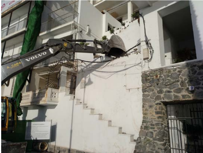
Lámina III. Zona del ascensor antes del inicio de los trabajos
