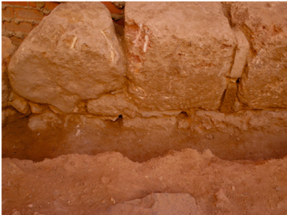
B. Detalle UEM 5.13, los intersticios entre sillares presentan ladrillos romanos
