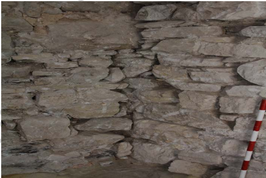
Muro de la fase I
