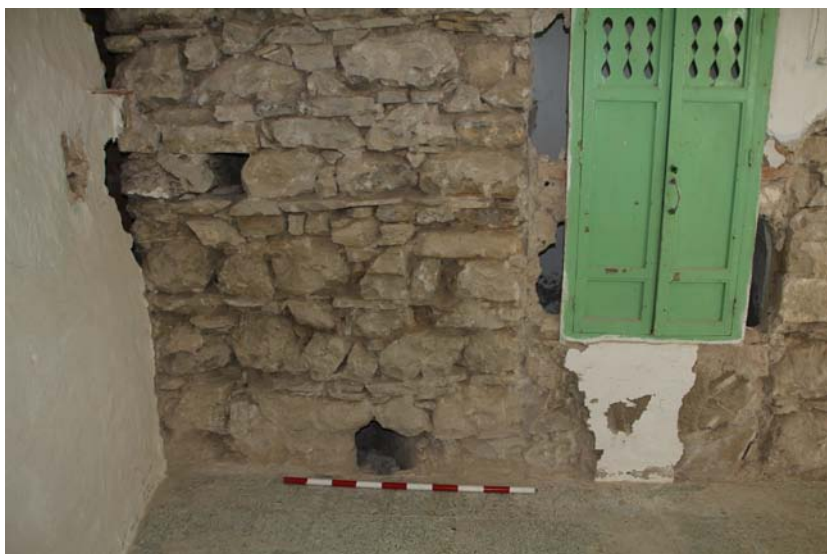
Muro de la fase III
