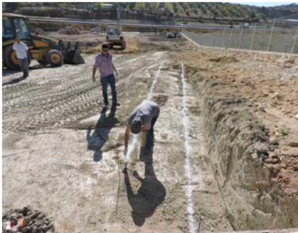
Fot. 3. Replanteo sobre el terreno del muro de contención occidental.
