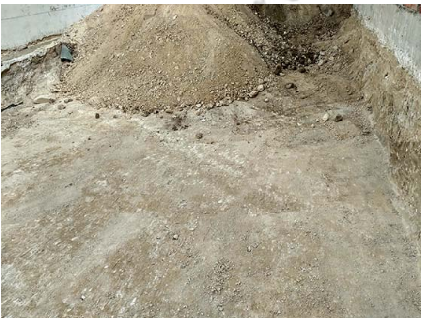
Fig. 2. Desarrollo de los trabajos.
