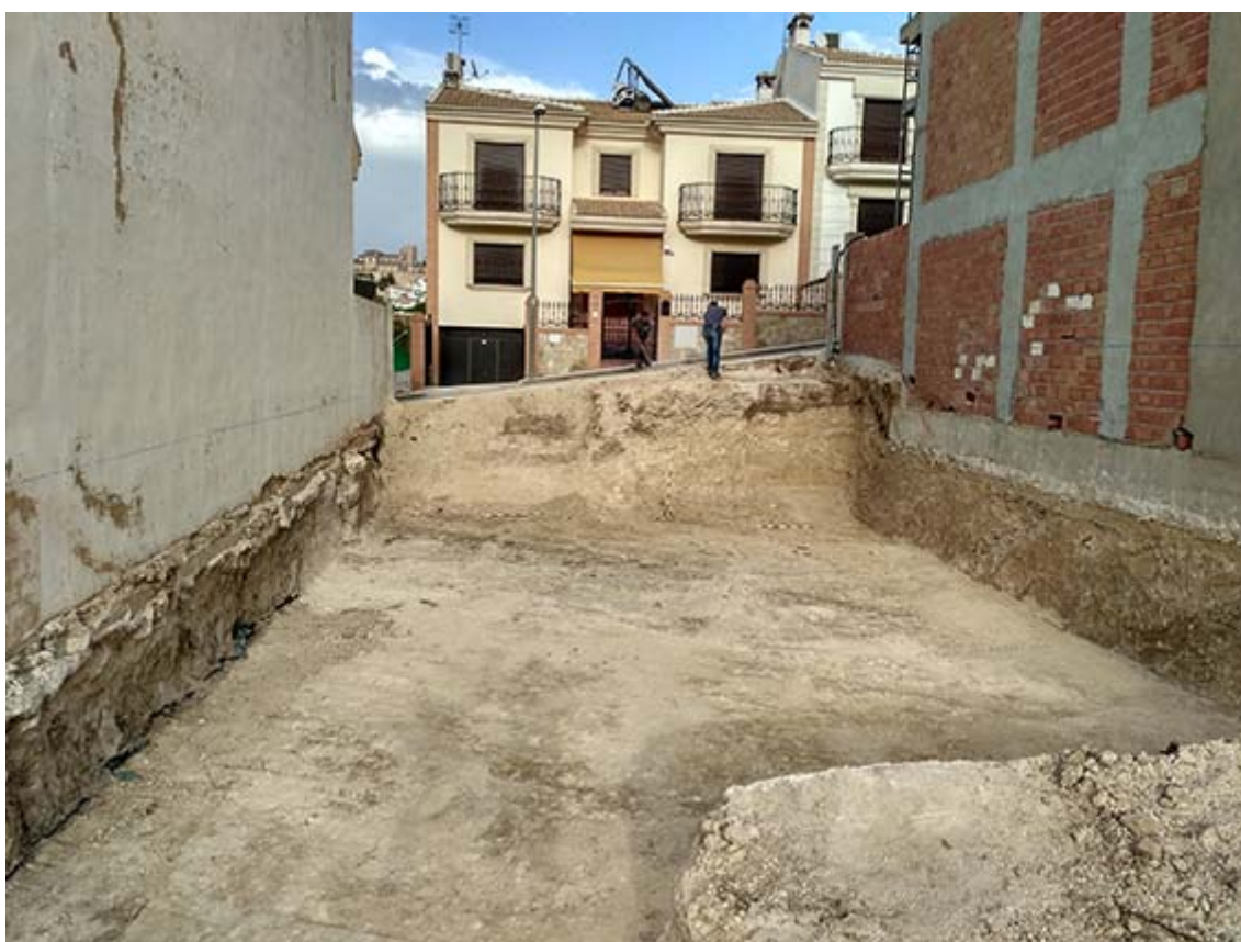
Fig. 3. Vista del solar desde el Este.
