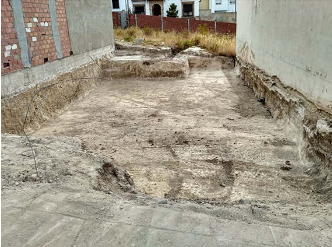
Fig. 4. Vista del solar desde el Oeste.
