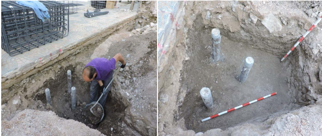
Lám 1 y 2: Excavación de las zanjas de micropilotes
