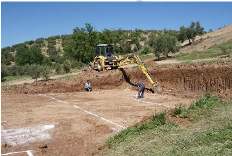
Fot. 3. Proceso finalizado de ejecución del cajeadado y replanteo de las zapatas perimetrales.
