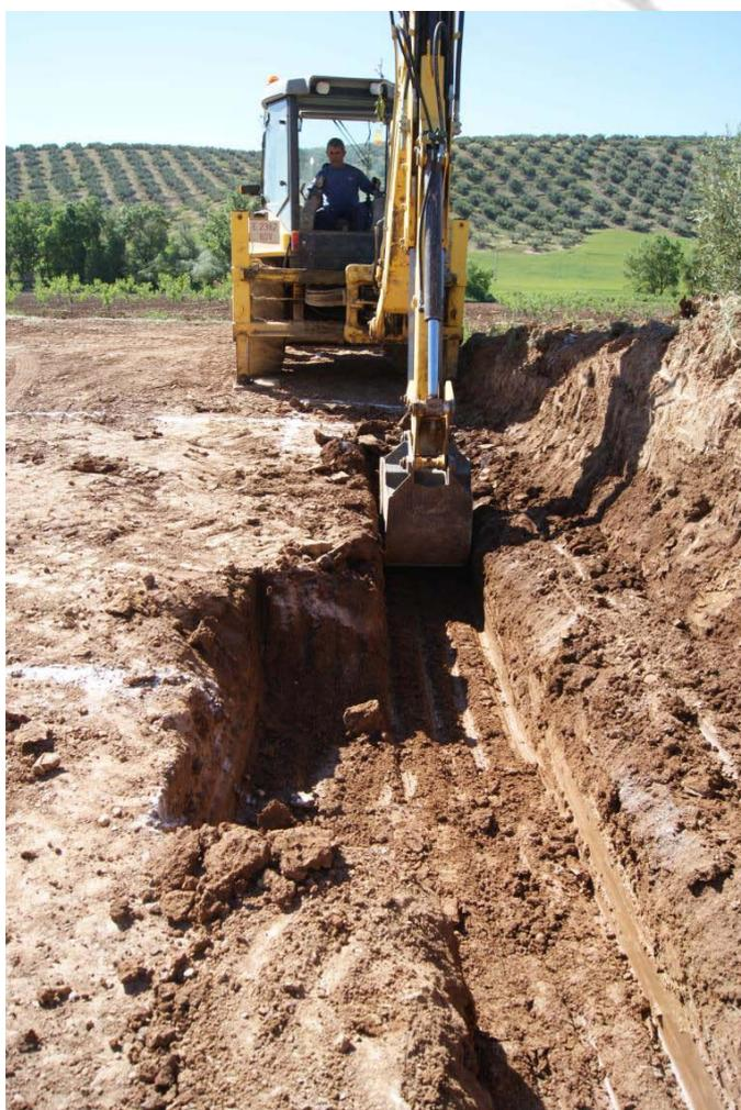
Fot. 4. Proceso de ejecución de la zapata perimetral y pozos para los pilares
