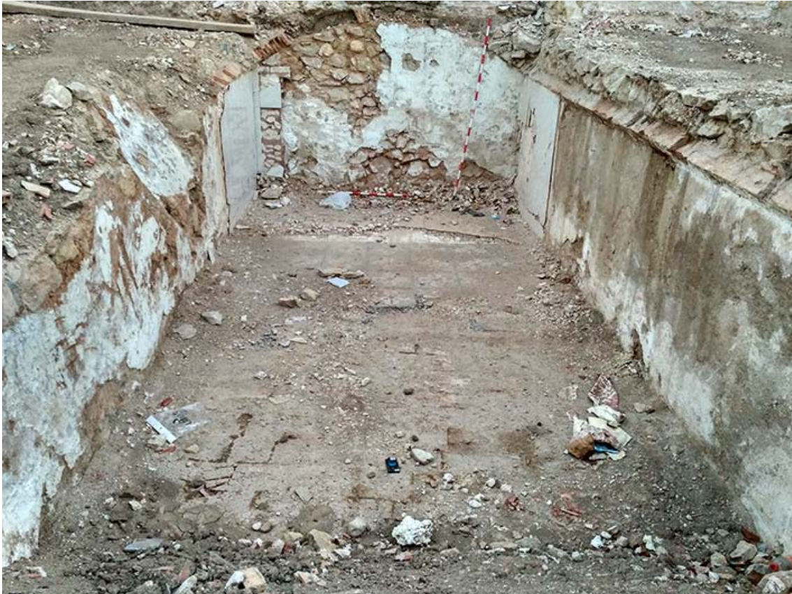
Fig. 2. Sótano existente en la casa demolida.
