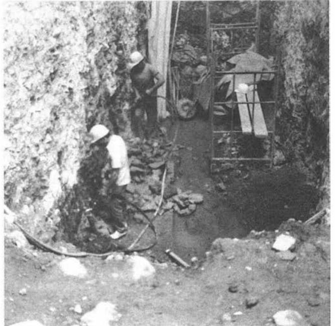
LAM. II. Momento de la destrucción de la línea de sillares mencionada y que provocó la paralización momentánea de la obra.
