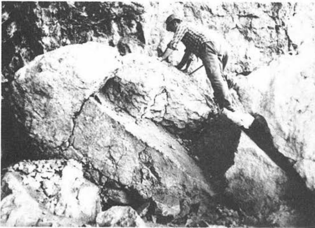
LAM. IV. Fotografía en la que se aprecia uno de los grandes bloques de piedra, en el momento que se empieza a desmontar para sacarlo piedra a piedra.
