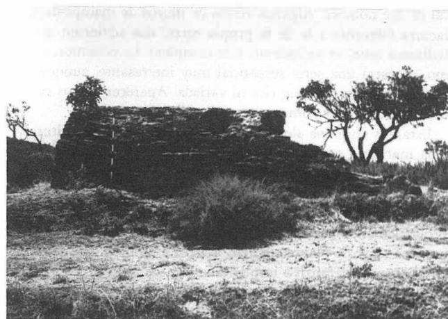
FOTO 7. Aljibe situado en el campo, cerca de una cañada de ganado, próximo a Rubite, en las proximidades del pico Gor (término municipal de Rubite).
