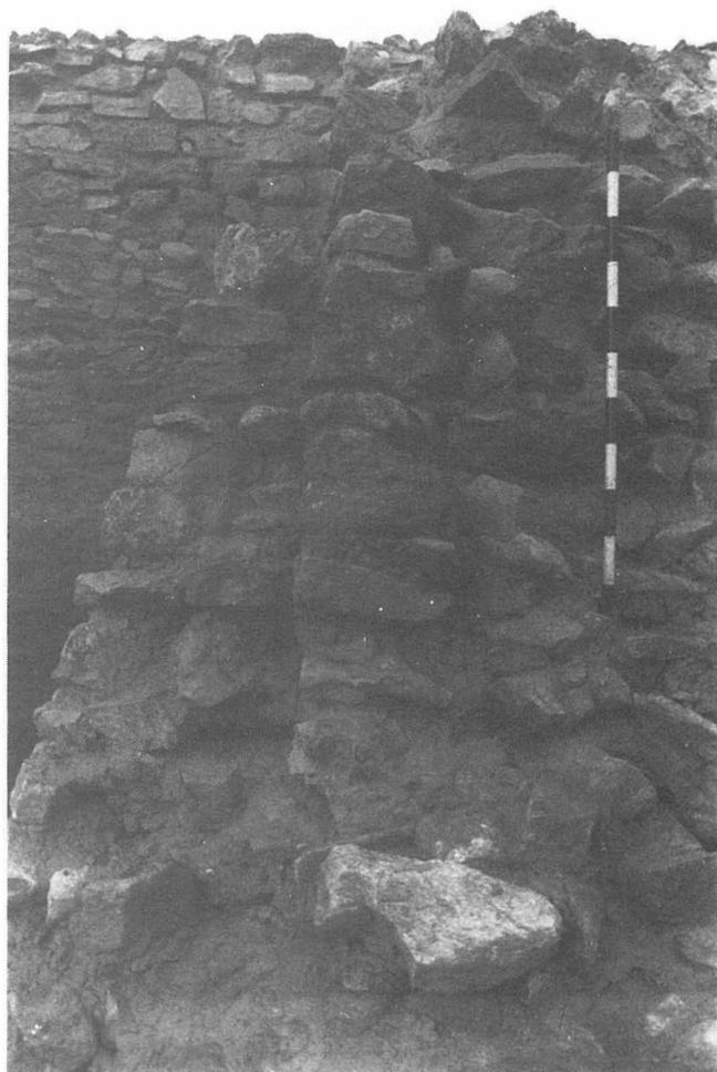
LAM. III. B. Detalle de la construcción en el bastión 7 donde se observa la construcción a plomada y el refuerzo en talud.
