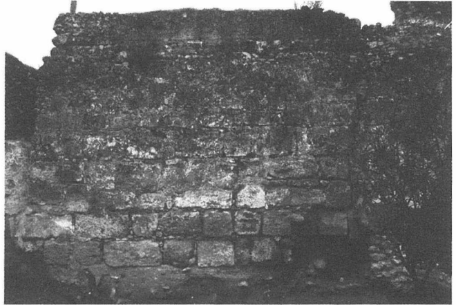
L.001. 1. Barbacana alta. Vista parcial de la muralla.
