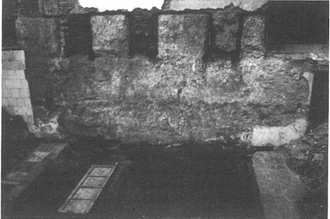
Lám. II. Lienzo de muralla aparecido en calle Marqués de Parada.
