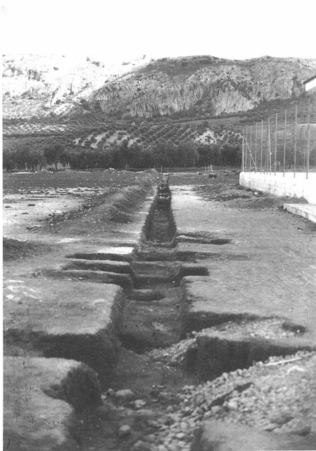
LAM. II. Vista general de la zanja oeste con las fosas de enterramiento en primer plano.
