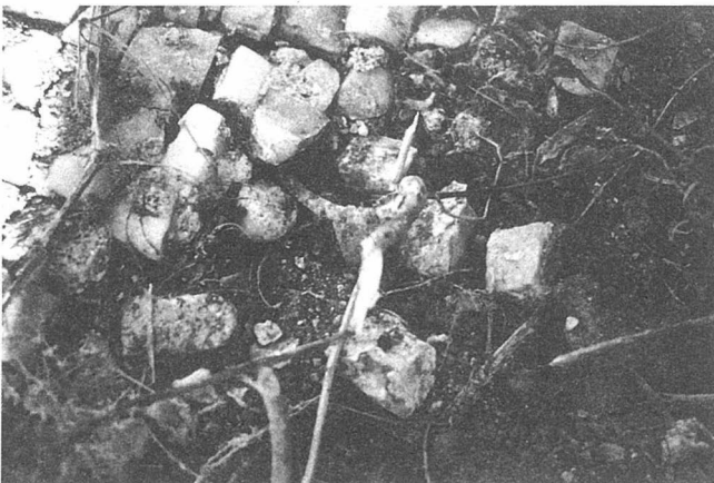
LAM. 5. Villa de Torrox. Incidencia de la vegetación en la disgregación de teselas.
