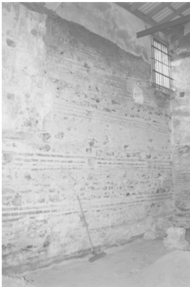
LAM. II. Vista del muro sur, cara interior.
