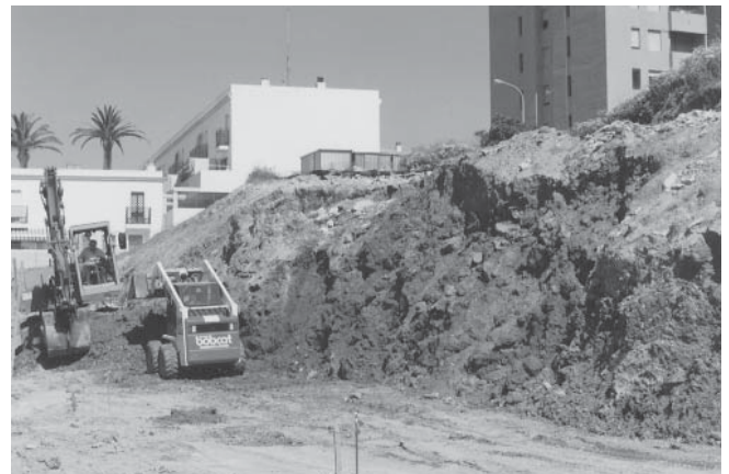
LAM. II. Vista general del seguimiento arqueológico del movimiento de tierras.
