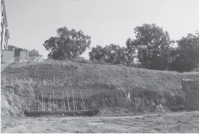
LAM. VII. La estructura tras su consolidación preventiva.
