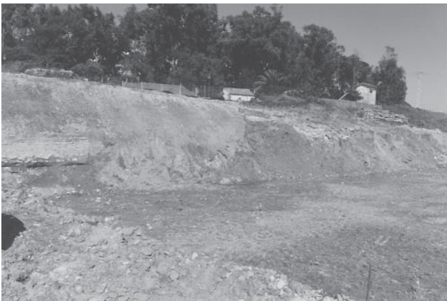
LAM. V. Vista general del talud, con el antemuro situado a la izquierda del espectador.
