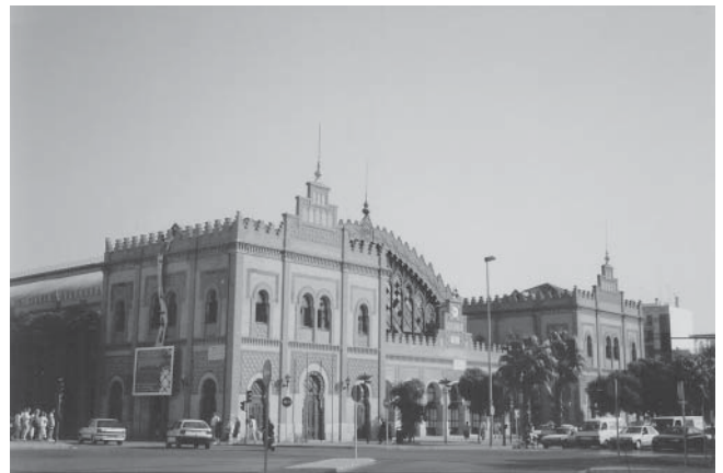
LÁM. II. Estado actual de la fachada del edificio.
