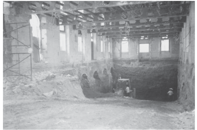
LÁM. V. Proceso de extracción de la tierra.
