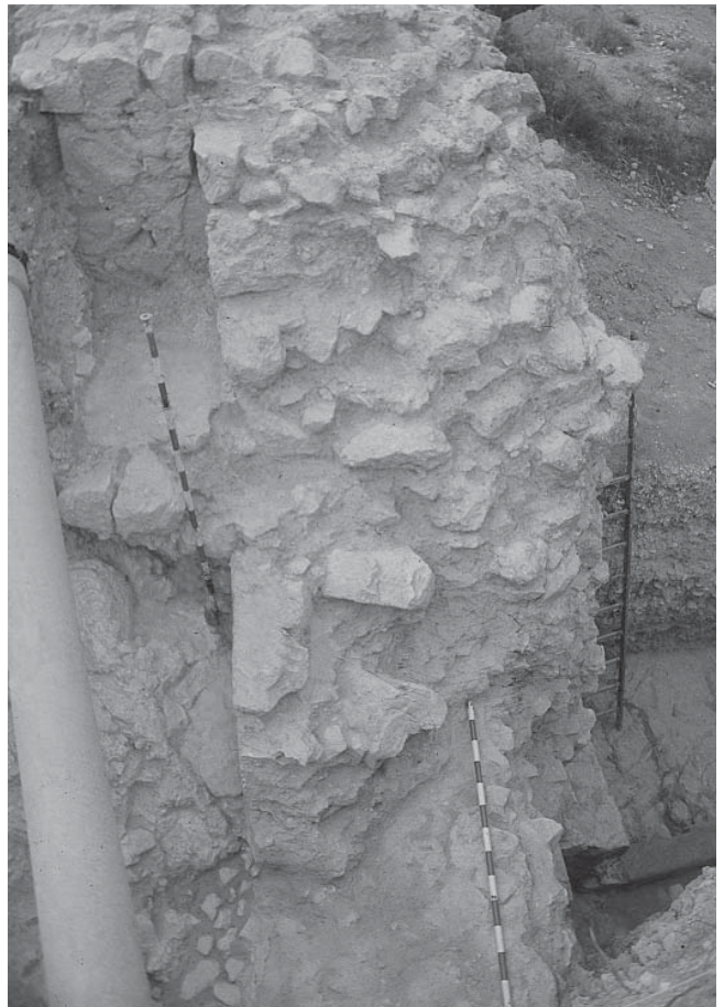
LÁM. II. Vista parcial del corte 2 desde el perfil E. Muralla y alzado lateral de la torre.
