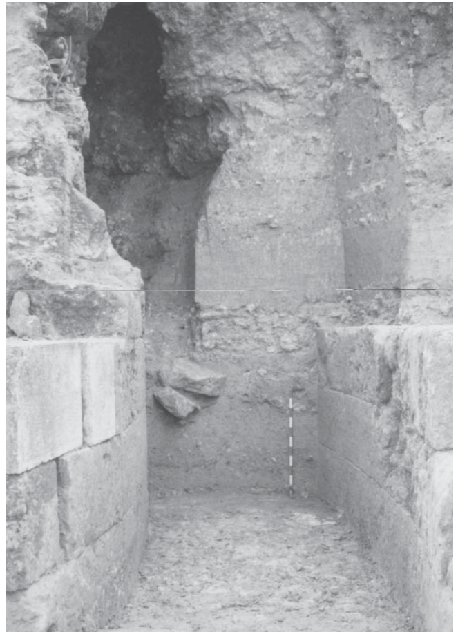
LÁM. III. Detalle de la Estancia 7 en el que se observa el corte estratigráfico con los niveles de expolio y ortostatos incrustados procedentes del pavimento de las gradas.
