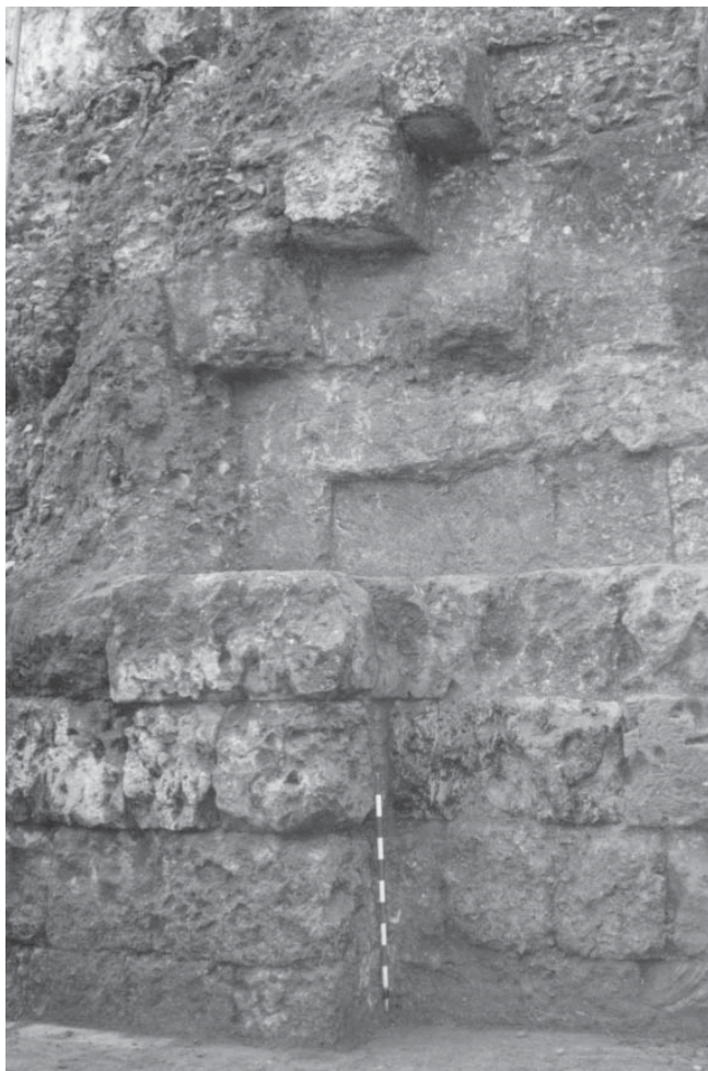
LÁM. I. Detalle del MT2 de la estancia 2 en el que se aprecia el expolio de los sillares de opus quadratum.
