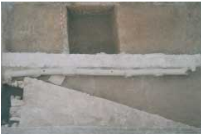
LÁM. VI. Plataforma del baluarte de la C/ Andrés Cassinello con su entrada.
