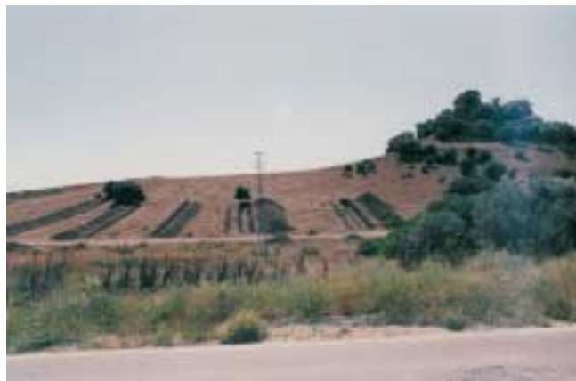
LAM. III. Aspecto de las zanjas excavadas en la ladera de Cerro Berroquero.
