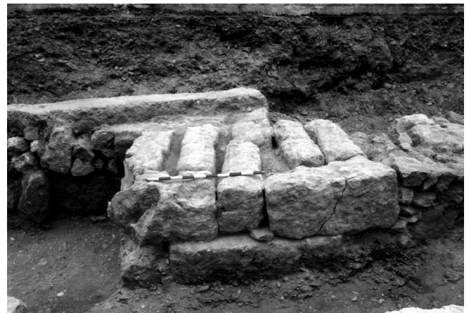
LÁM. II. Detalle de la cara sur del muro UE 6 en donde se aprecia las dos hiladas de sillares y las gravas geológicas sobre las que se asientan. Al fondo restos de un posible pavimento UE 15.
