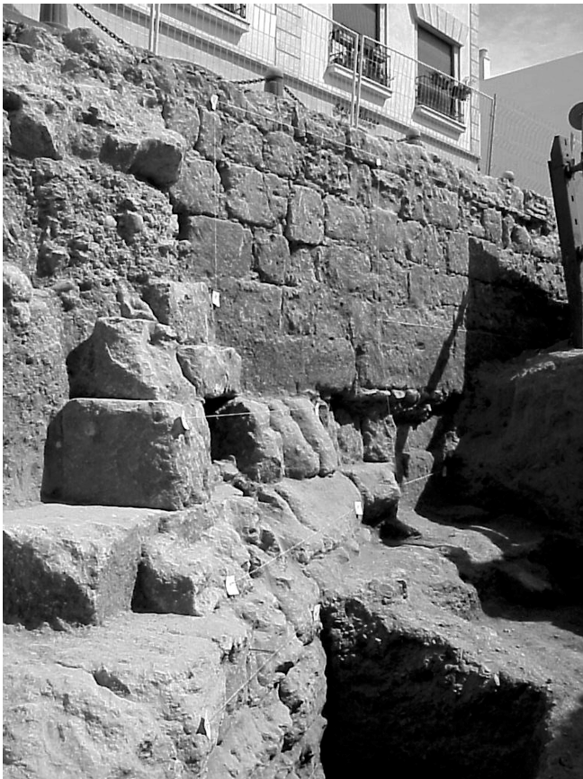
LÁM. IV. Detalle de la superposición de estructuras UUEE 8 y 9 del corte nº 1.
