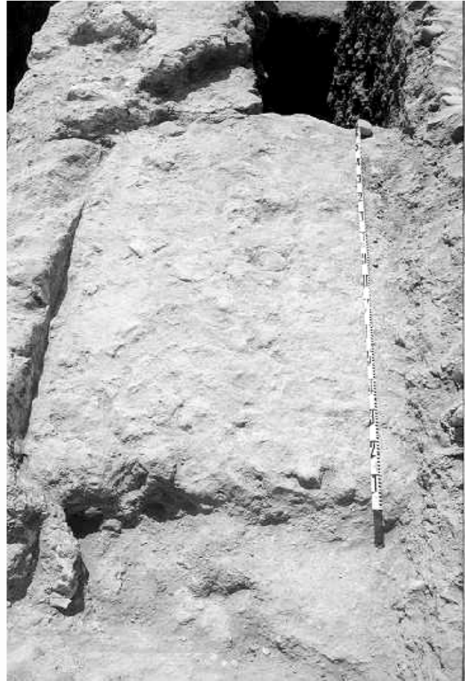
LÁM. I. Fase 2. Riñón (U.E. B-33) del arco septentrional del puente romano y posible pavimento del tablero del mismo (U.E. B-40). Época augustea.
