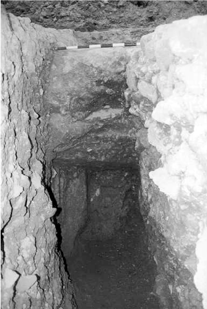
LÁM. I. Fase 2. Riñón (U.E. B-33) del arco septentrional del puente romano y posible pavimento del tablero del mismo (U.E. B-40). Época augustea.
