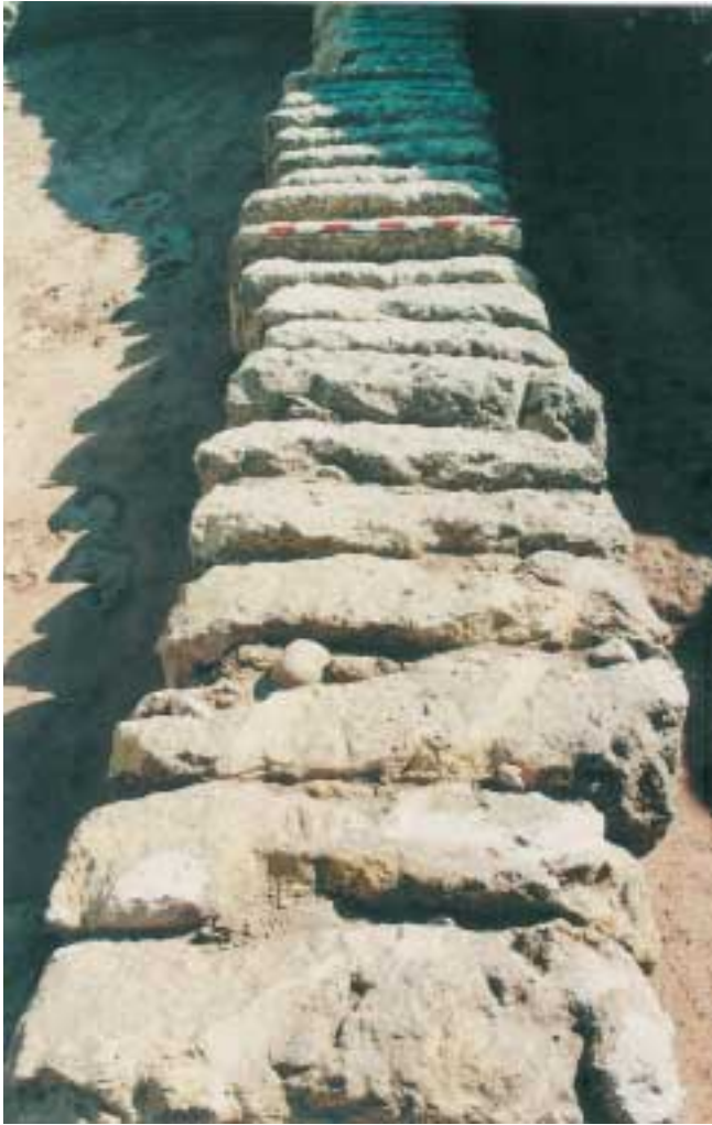
LÁM. III. Corte 4. Detalle del aparejo del cimiento 1, con sillares atizonados, de época califal.
