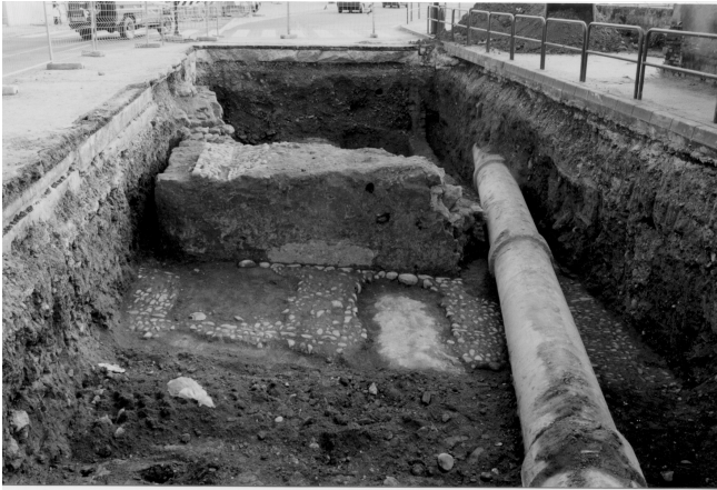
LÁM. II. Restos de la Torre de las Siete Menas desde el W.
