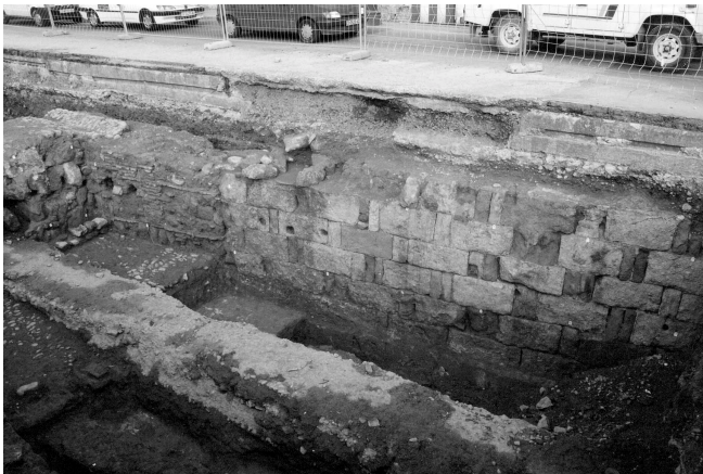
LÁM. IV. Vista general de la muralla donde se aprecia su técnica constructiva.
