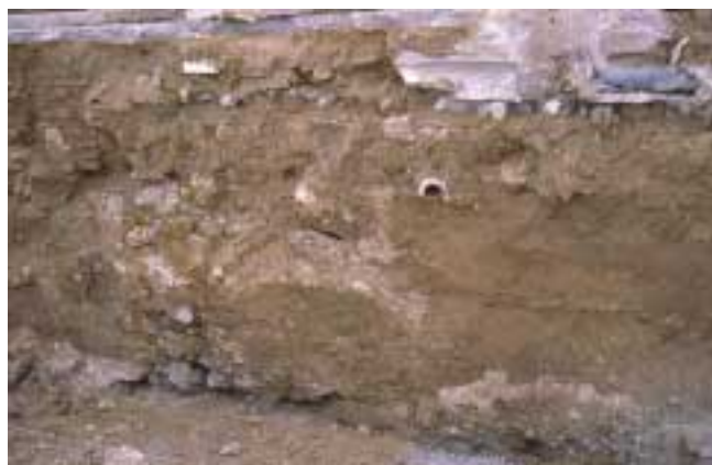
LÁM. VI. Nivel de conservación de la muralla bajo el pavimento de la plaza.
