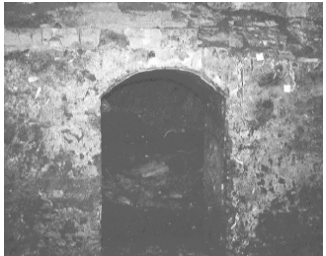
LÁM. I. Arco escarzano en M-30.
