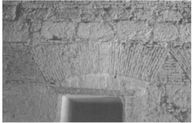
LAM. II. Muro nº 2. Detalle de los bloques de hormigón recortados, procedentes de la muralla y reutilizados en los principales muros de la edificación de 1872.
