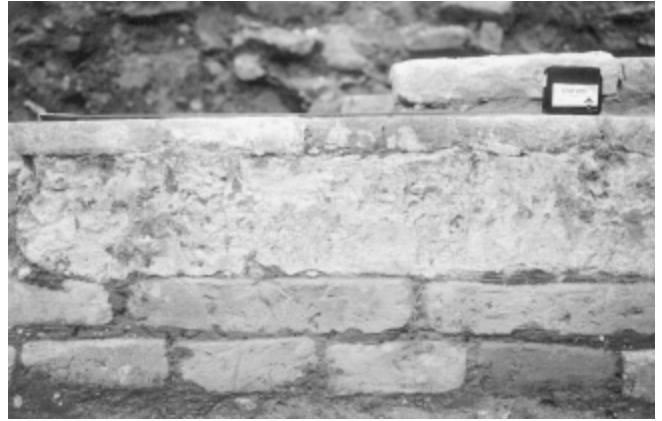
LÁM. V. Estructuras mudéjares. Detalle del revestimiento.
