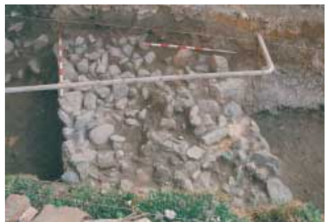
LÁM. I. Plano general estructura de cimentación medieval.
