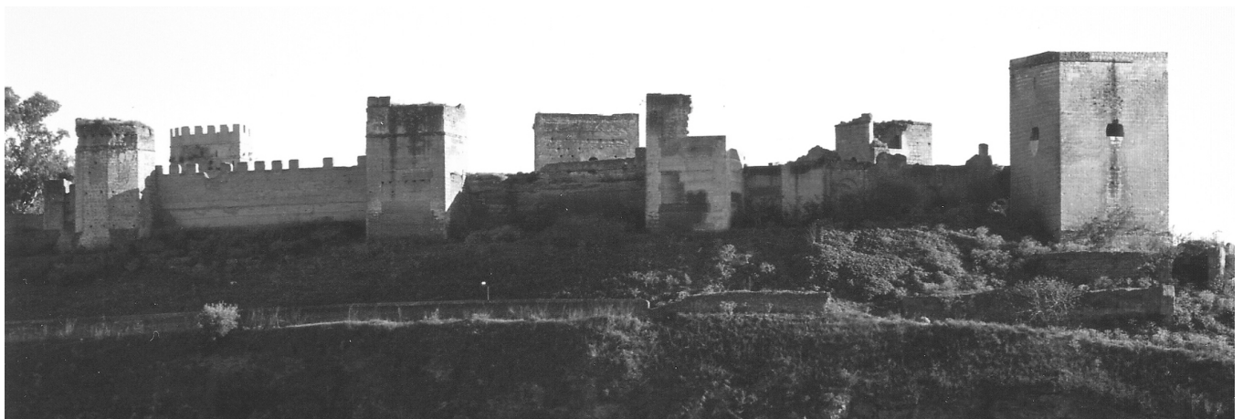
LÁM. I. Vista del sector noroccidental del Complejo desde el Norte
