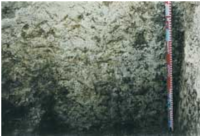
LÁM. VIII. Detalle del enfoscado del jardín hundido del patio de andenes.
