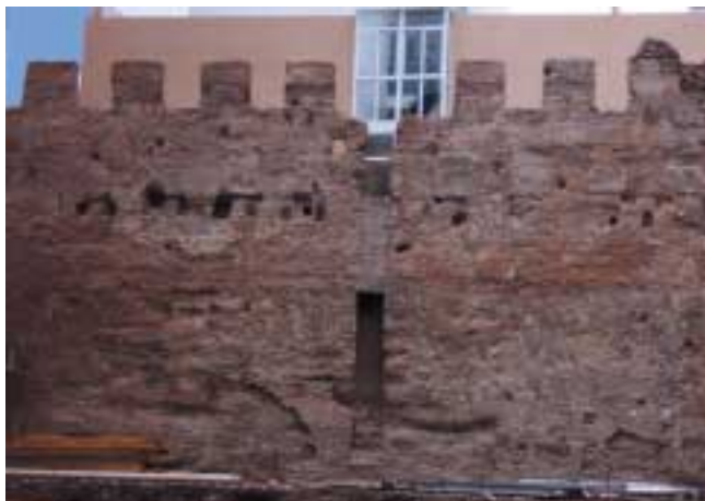
LAM. IV. Vista general de la muralla.
