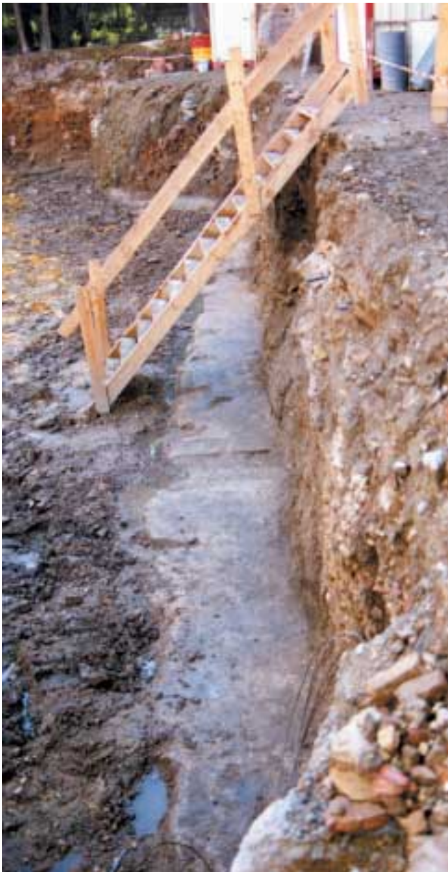
LAM. I. Vista general de los restos documentados de la barbacana.
