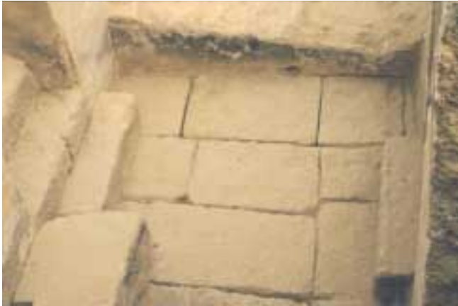
LAM. III. Bancos y pavimento de la cámara central
