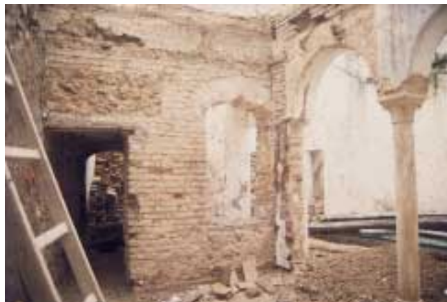
LÁM. I. M a Auxiliadora 5. Aspecto de las estructuras interiores del edificio durante su rehabilitación.
