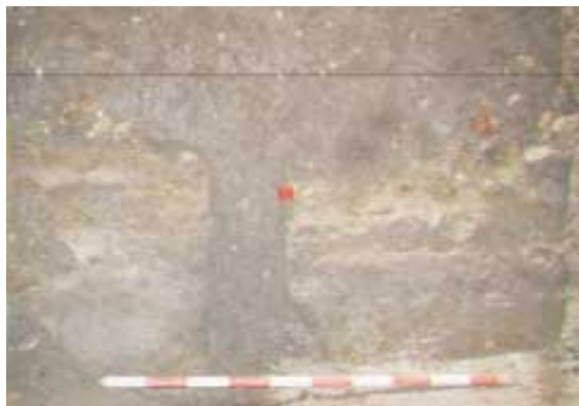
LÁM. II b. Detalle de la Estructura Muraria (UE 41)
