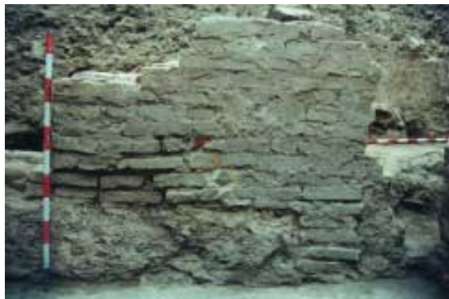
LAM. I. Detalle del muro de técnica mixta de sillares y ladrillos (U 12).
