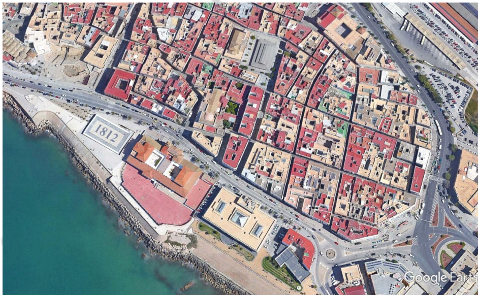
Lám.II: Detalle de la finca en el entorno del Barrio Santa María.
