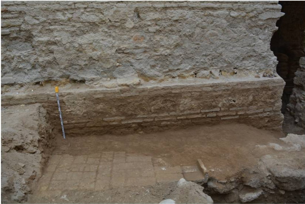
Lám. VI. Detalle de la fábrica del muro UE:-14 a nivel de cimentación. Vista desde el norte.
