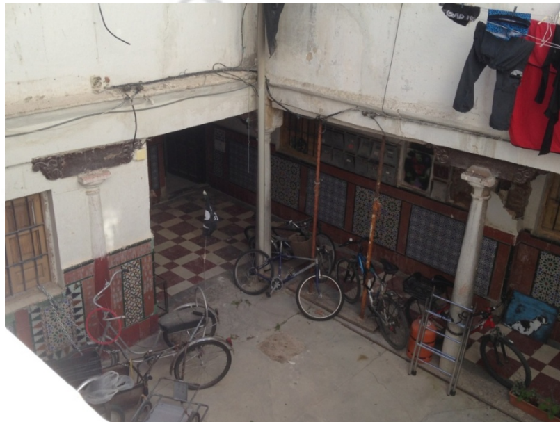
Vista general de las columnas del patio y galería. Estado actual.
