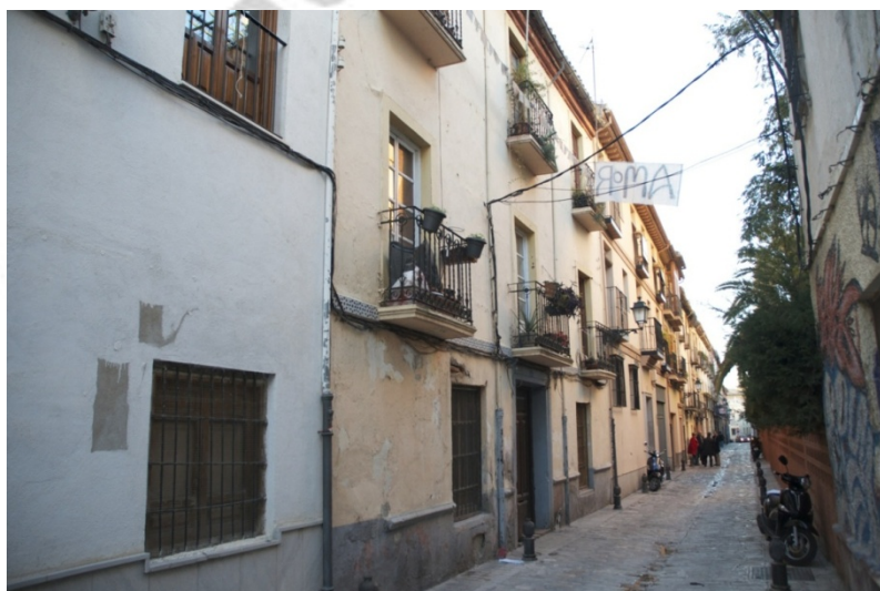
Vista de la fachada. Estado actual
