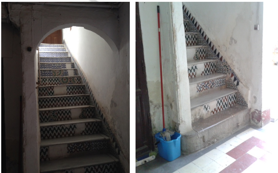
Escalera 1 en el zaguán. Estado actual.
