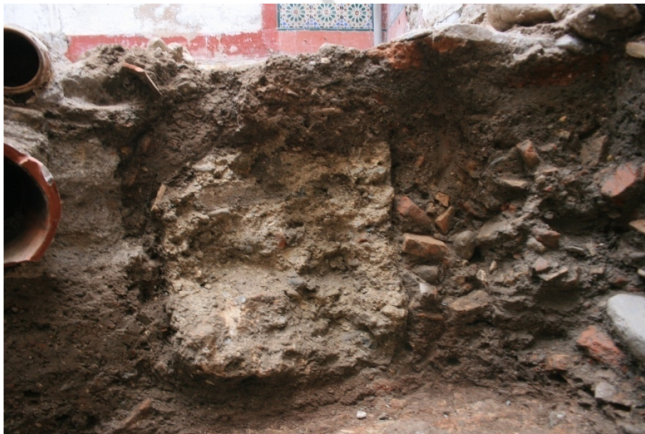
Foto 6. Detalle de los restos de muro de tapial de época medieval (MR-039) documentado gravemente afectado por las afecciones en el subsuelo de época actual.
